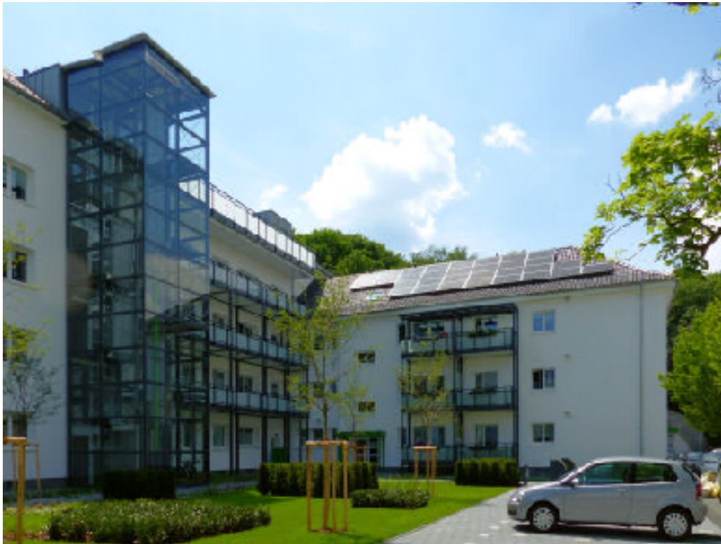
Klimaschutzsiedlung, Siegen Architekten GmbH, Köln
