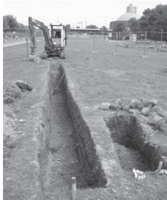
August 2007: Bagger beim Bodenaushub für das Fundament.
