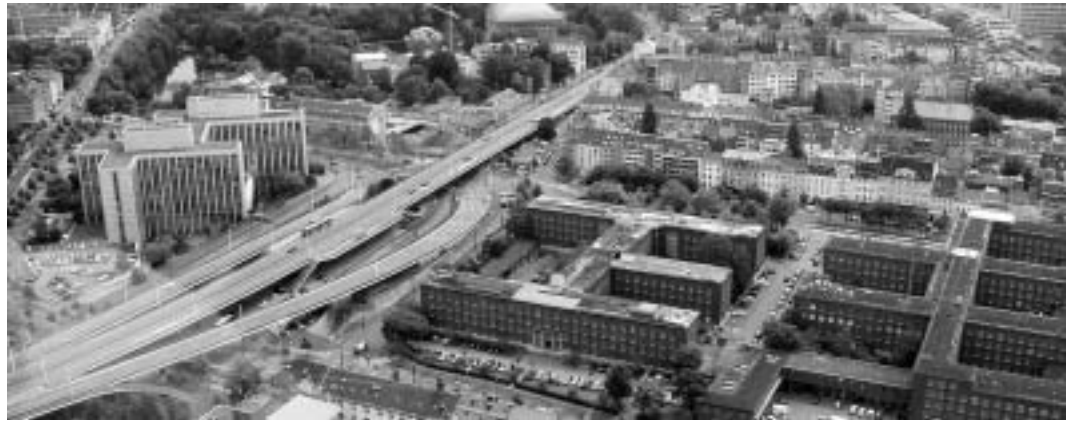
Abriss- und Neubauiden gibt es links und rechts der Kniebrückenrampe.
