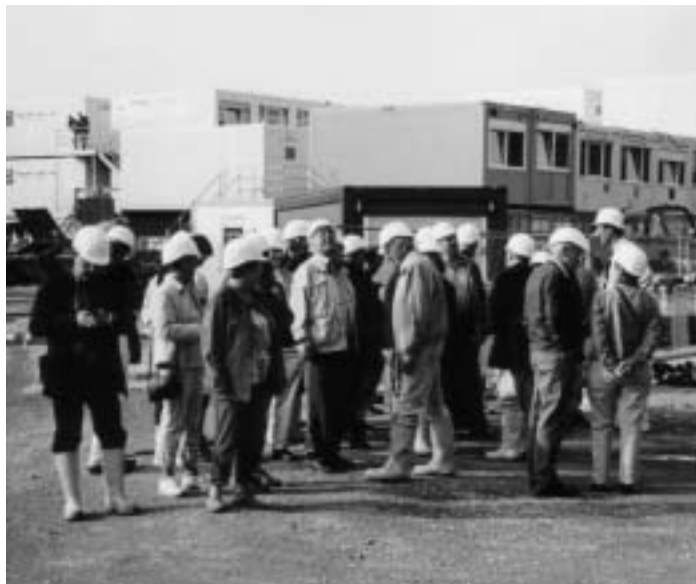
Hechte unter Helmen: Baustellenbesuch.
