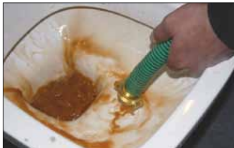
Verfärbungen von Wasser sind störend für Mieter und Hausbesitzer. Die Luft-Wasser-Spülung kann helfen.
