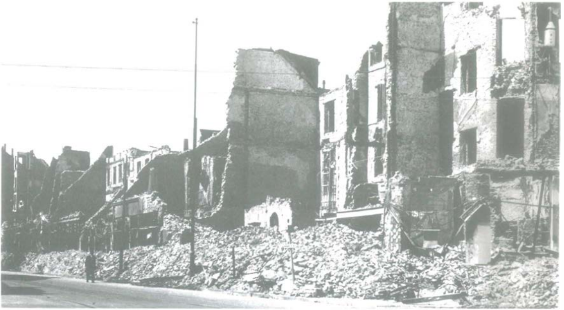
Nur ein Trümmerhaufen noch war auch die Shadowstraße, hier die Nordseite.
