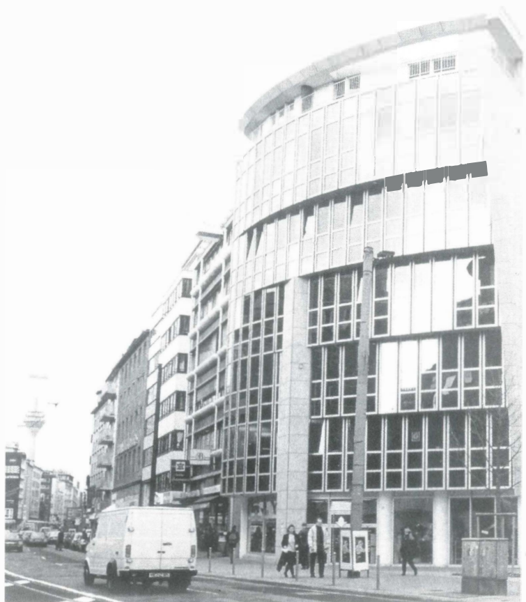
Moderne Bürohausarchitektur: Das neue „Leve und Kobs-Haus“ in der Graf-Adolf-Straße.
