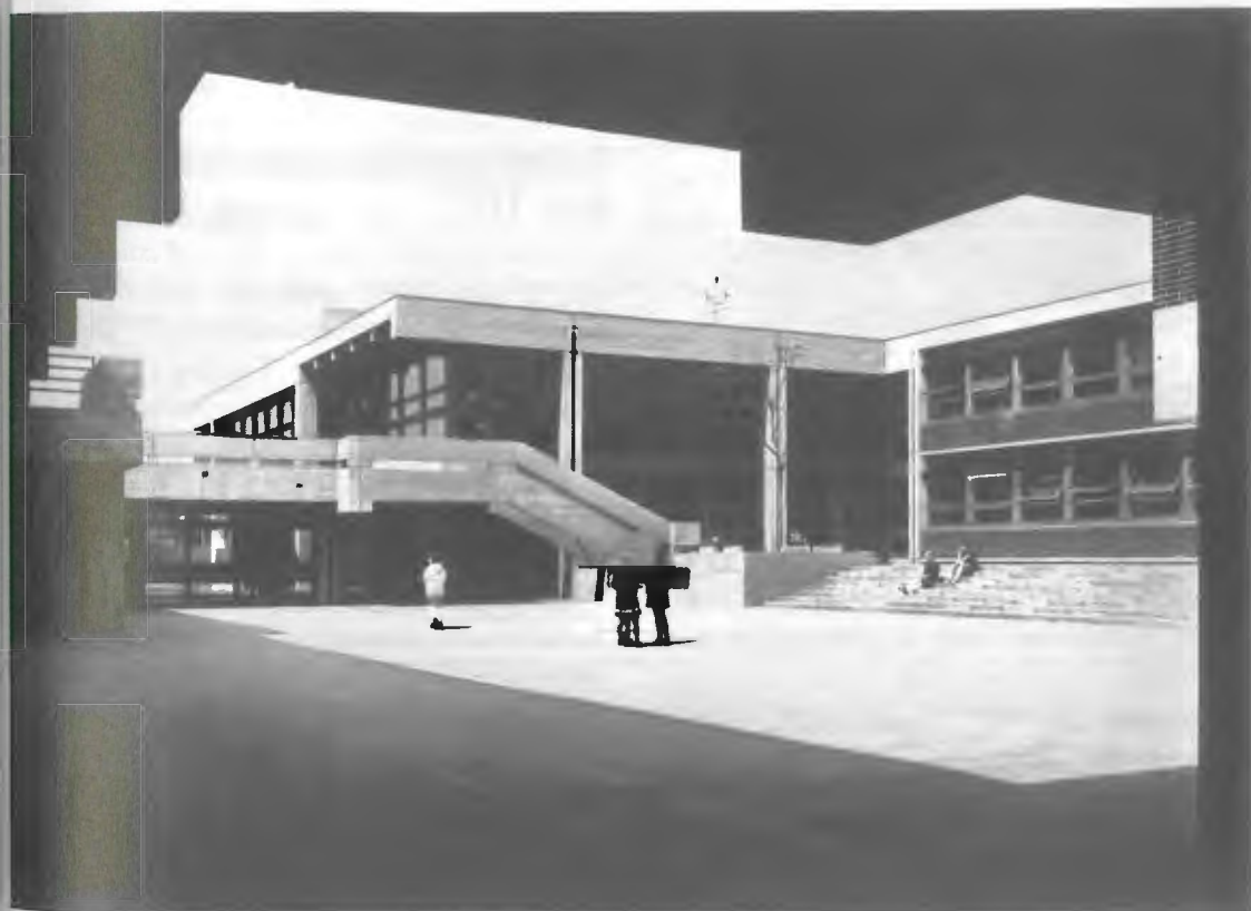
Theodor-Fliedner-Schule, Teilansicht von Osten mit Innenhof
