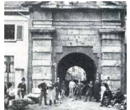
Abrissarbeiten am Berger Tor 1895, gesehen von der Rheinseite
