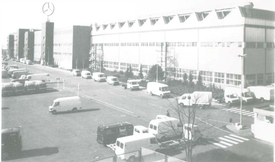
Das Werk Düsseldorf der Daimler-Benz AG wurde in den letzten Jahren zum zentralen Transporter-Werk des Unternehmens ausgebaut. Jährlich verlassen bis zu 70 000 Transporter die Hallen. Bild: Mercedes
