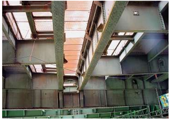
Ansicht der Kardinal-Frings-Brücke von unten.
