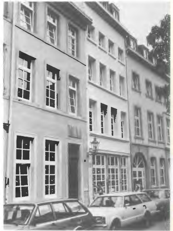
Das Carl-Sonnenschein-Haus (links) in der Neubrückstraße ist zum Studentenwohnhaus umgebaut worden (Bild: Frank Pierlings)
