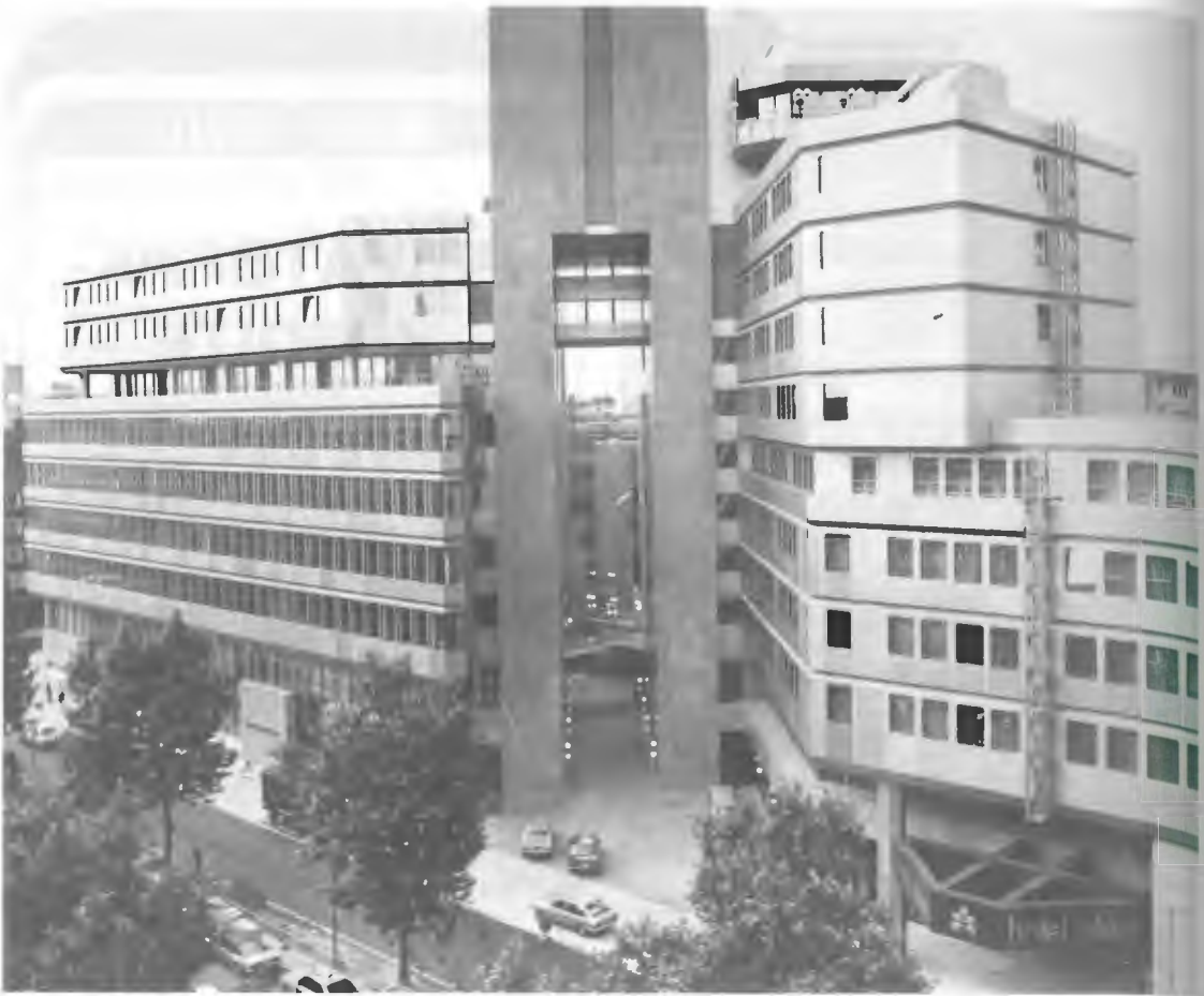
Blick auf das Japan-Center an der Immermannstraße
