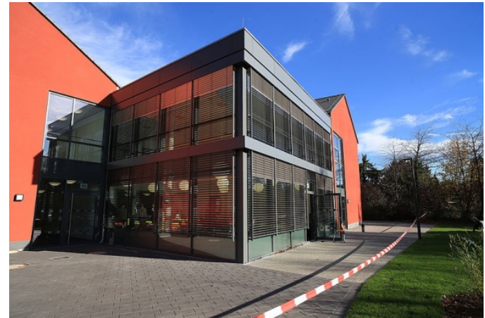
Erweiterungsbau Montessori-Grundschule Farnweg 10
