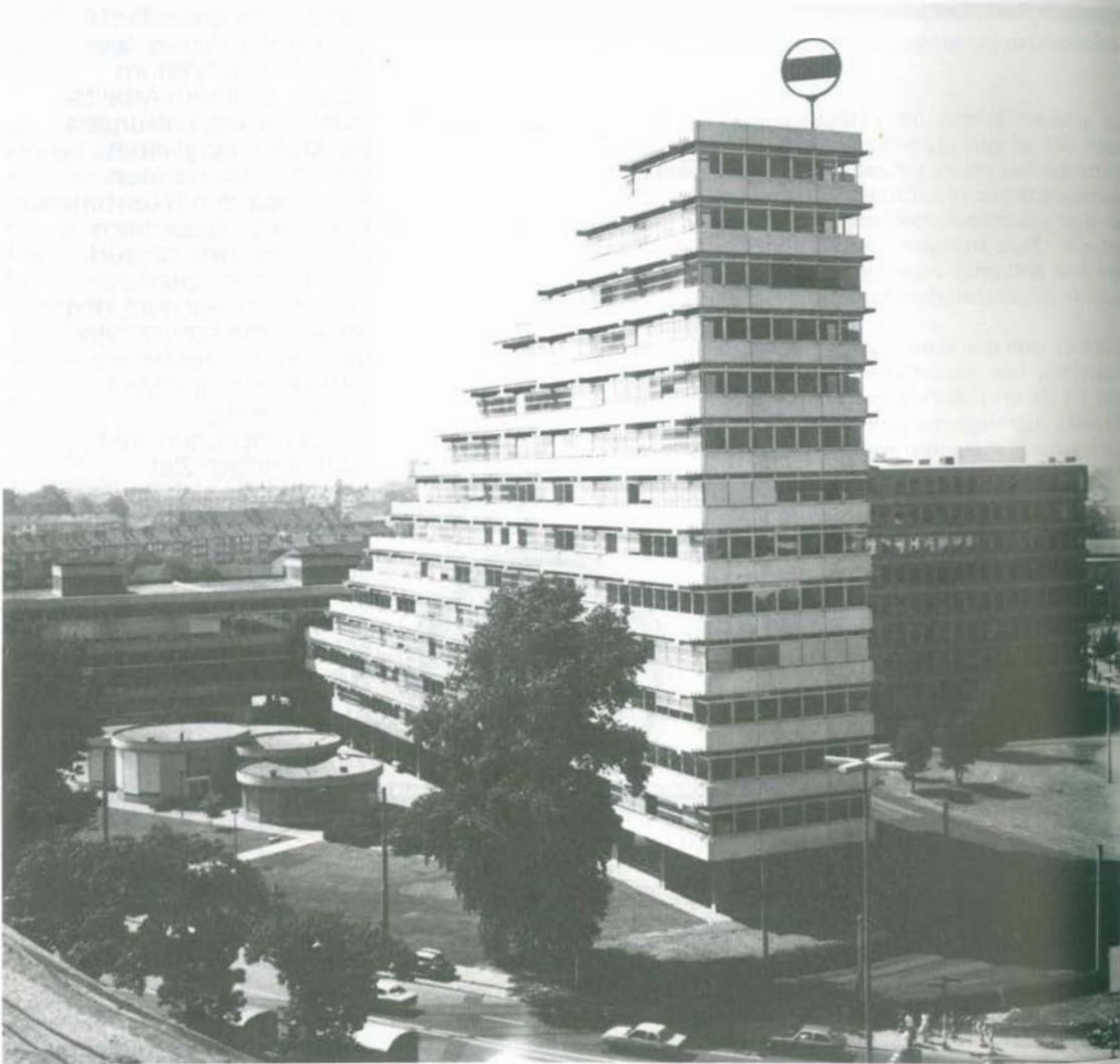
Das ARAG-Hochhaus am Mörsenbroicher Ei
