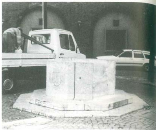
Der Fischerjungen-Brunnen nach der Demontage der zu restaurierenden und zu erneuernden Teile.
