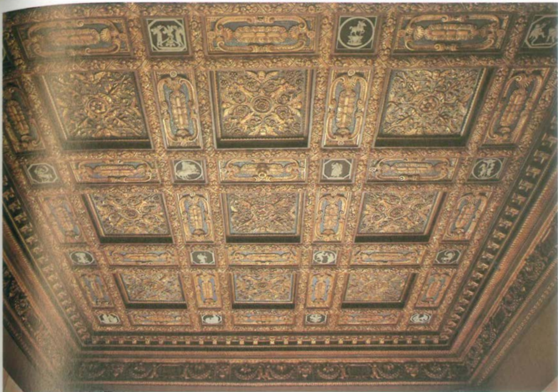
Königsallee 49, Deutsche Bank AG, restaurierte Decke
