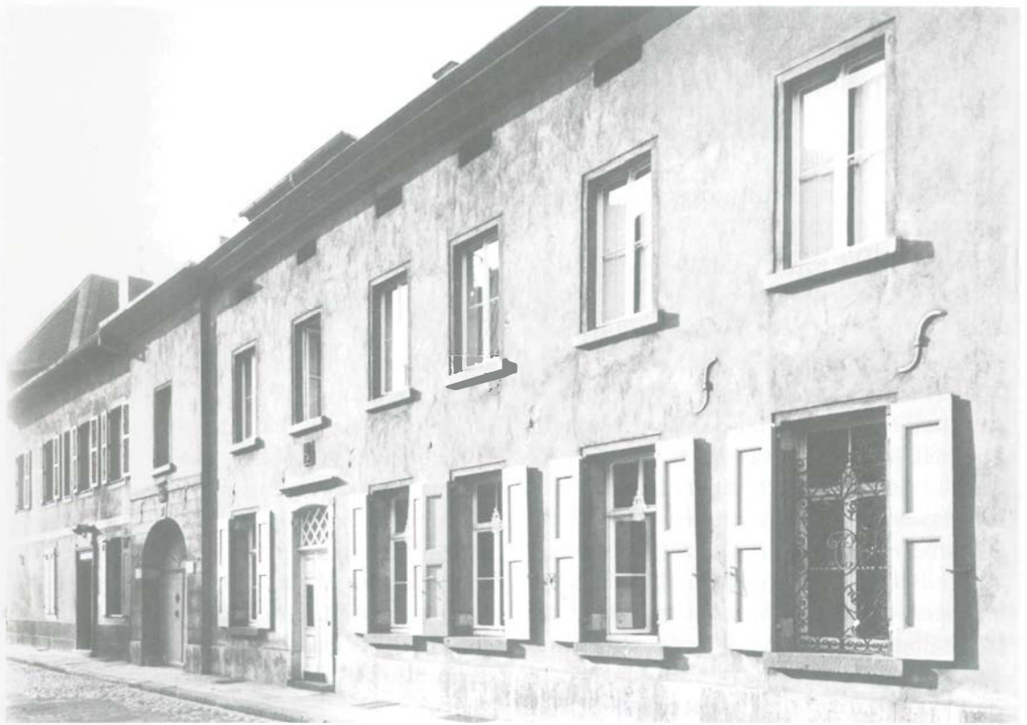
Ritterstraße 2-4 mit Wappensteinen (Foto Landesbildstelle 1970)
