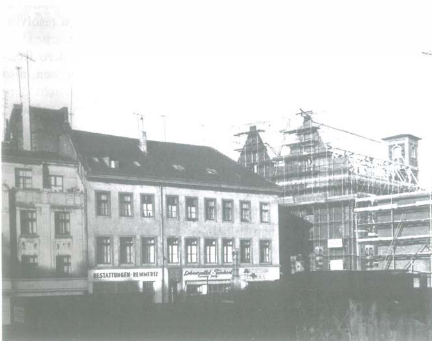
Alttestadt 10, 12, 14 während der Wieder- herstellung der Kreuzherrenkirche 1960 (Foto Landes- bildstelle)
