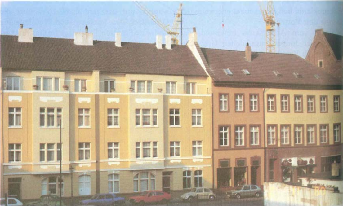
Altstadt 10, 12, 14 nach der Restaurierung 1980 (Foto van der Wippel)
