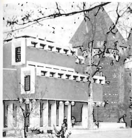
Das Clemens-Sels-Museum in Neuss, eine mutige moderne Architektur, verbunden mit dem Obertor aus dem Befestigungswerk um die Mitte des 13. Jahrhunderts.
