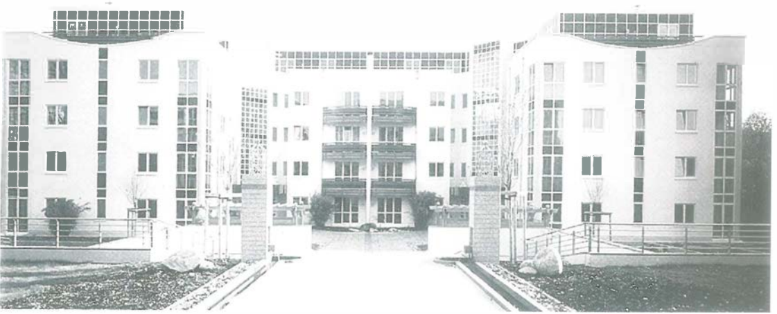
Wohnhäuser Lewittstraße, Düsseldorf-Oberkassel
