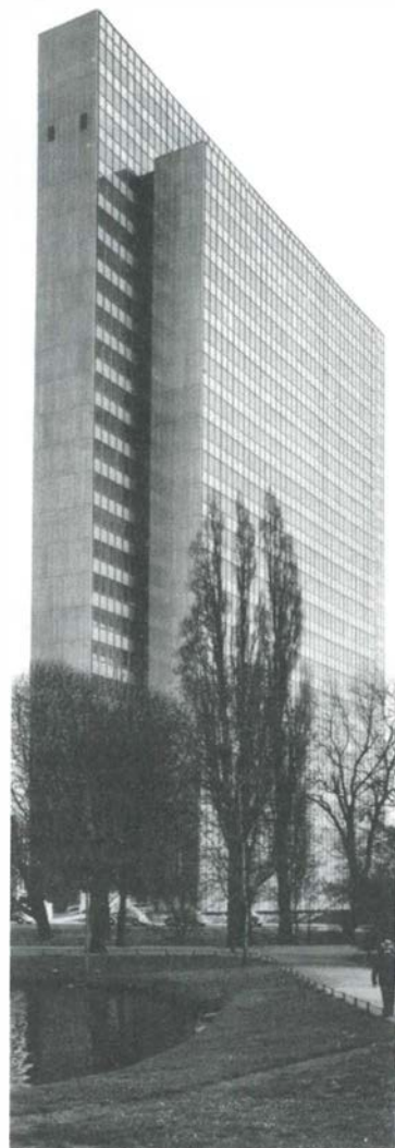
Aufsehenerregend und immer wieder als kühne Leistung moderner Architektur gewürdigt: das Thyssen-Dreischeibenhaus von Hentrich/Petschnigg.
