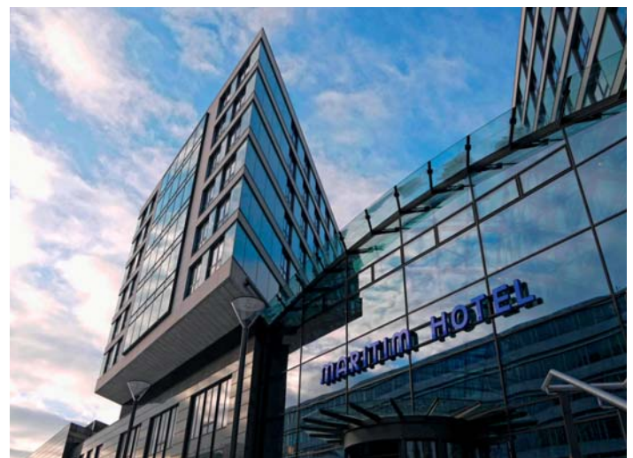
Das Maritim-Hotel ist ein Blickfang des neuen Stadtteils unmittelbar neben dem Flughafen.
