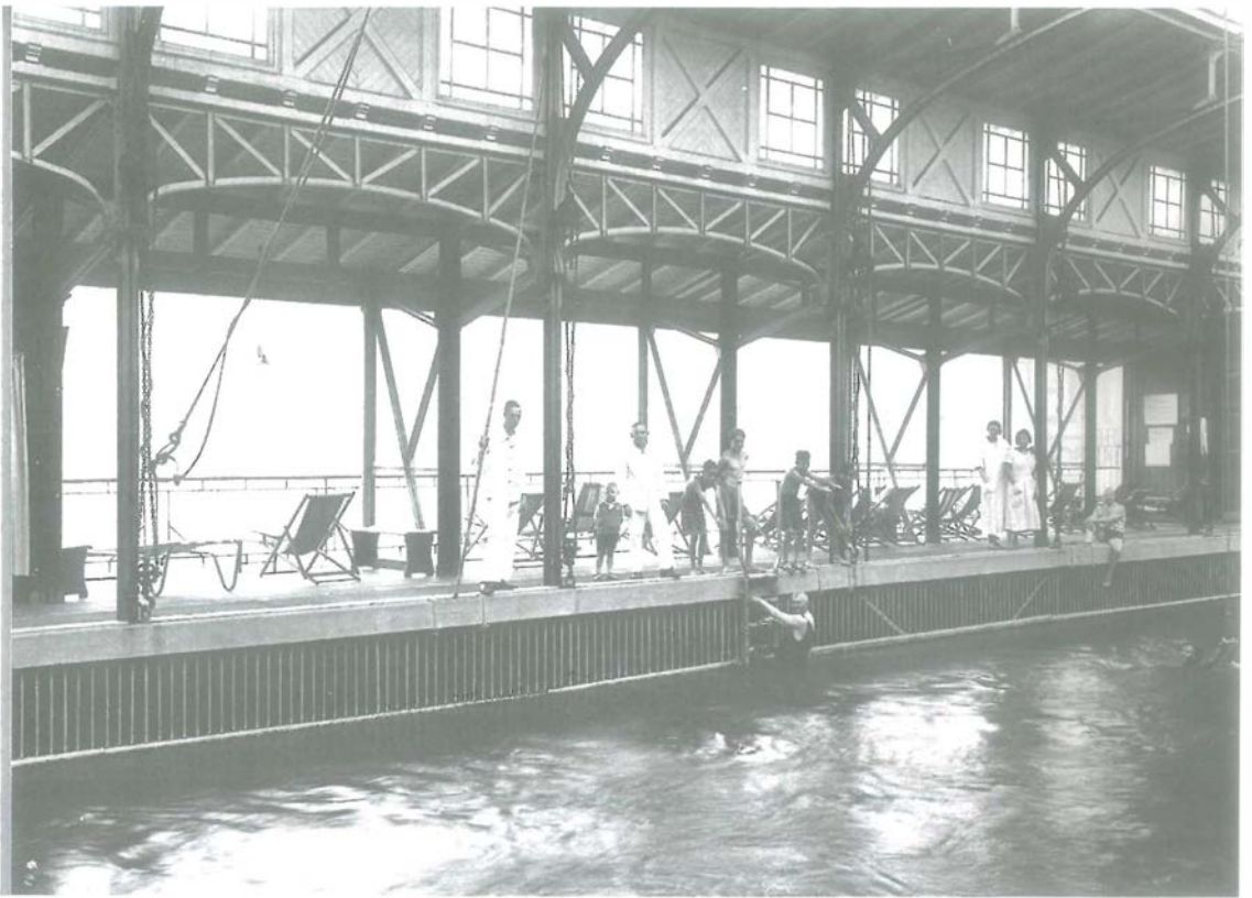
Blick in die alte Rheinbadeanstalt aus den Anfängen des Jahrhunderts; sie wurde im Zweiten Weltkrieg verschrottet.
