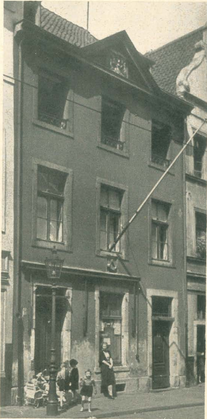
Das Haus „Zum Schwarzen Horn“ in der Ratinger Straße, das im 14. Jahrhundert der Stadt Düsseldorf als Rathaus diente. Heute befindet es sich in einem bedenklichen Bauzustand, und es wird wohl nicht lange mehr dauern, dann stürzt es in sich zusammen . . .
