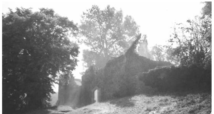
Abbruch der Helena-Kapelle.
