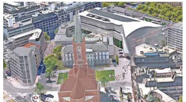
Mit bis zu elf Metern ist der „Calatrava-Boulevard“ deutlich größer als das Baudenkmal Justizministerium.
