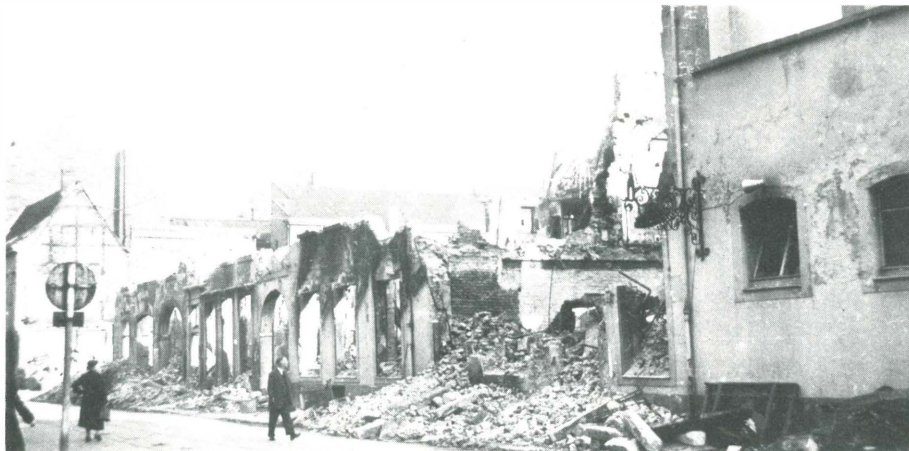
Vereinsheim in der Brauerei Schlösser nach der Zerstörung am 11.9.1942
