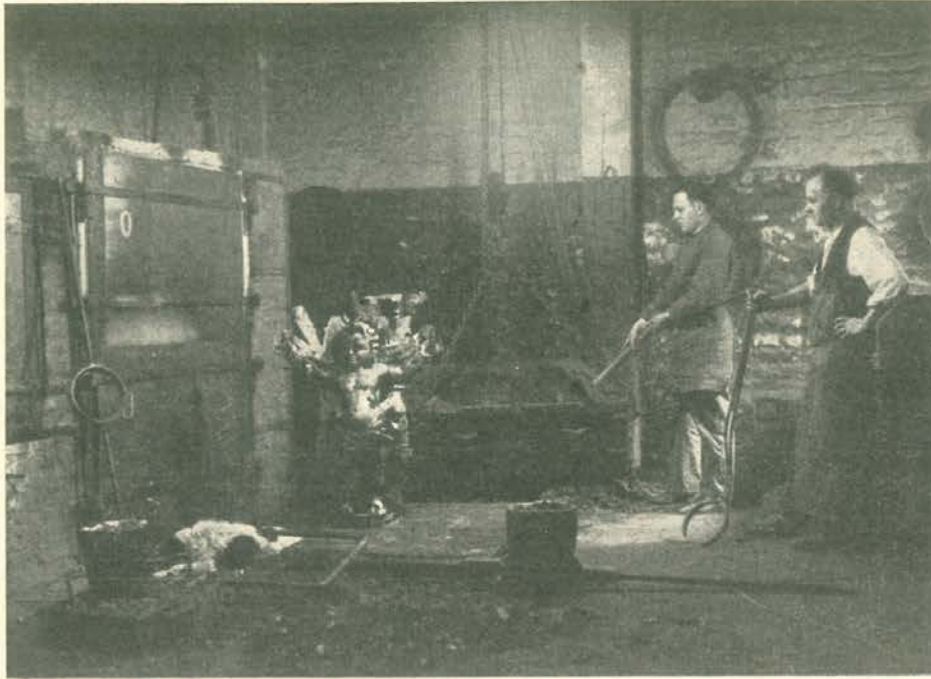
In einer Düsseldorfer Gießerwerkstatt
