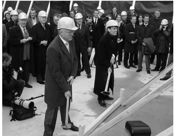
Zusammen mit Ministerpräsident Jürgen Rüttgers bei der Grundsteinlegung für Bürgersaal und K20-Erweiterung.
