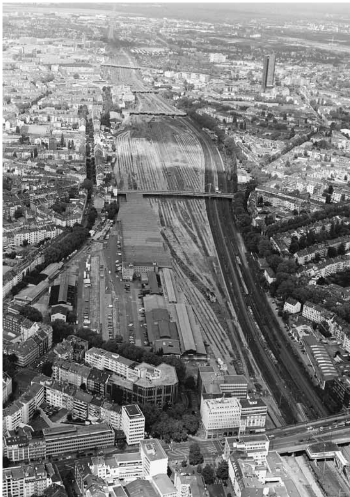
Kernstück eines neuen Grünrings wird das Gelände des ehemaligen Güterbahnhofs. Fotos (4): Dezernat für Planen und Bauen
