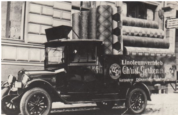
Lieferwagen der Firma Gerken mit einer Ladung Linoleum
