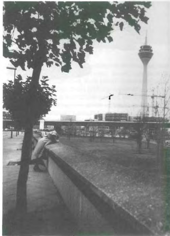
Blick auf den Rheinturm und den stetig wachsenden Landtagsbau (Foto: Gräf)
