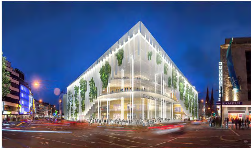
ProjektSchmiede / Meyer Architekten
