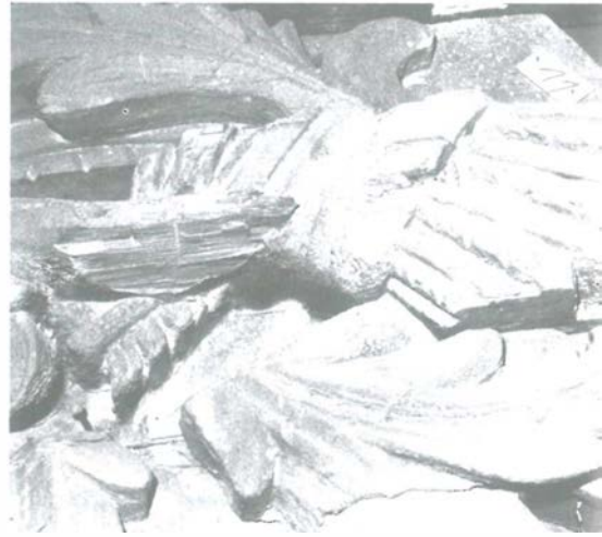
Detail des hölzernen Giebfeldes — die Absplitterung ist deutlich zu erkennen.
