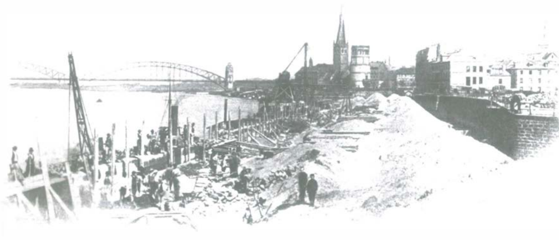
Baustelle Rheinufer um die Jahrhundertwende. Damals wurde das Ufer um 30 m vorgeschoben. 1896 war mit den Arbeiten begonnen worden, am 8. März 1902 wurde die Promenade eröffnet. Bilder: Presseamt Stadt Düsseldorf
