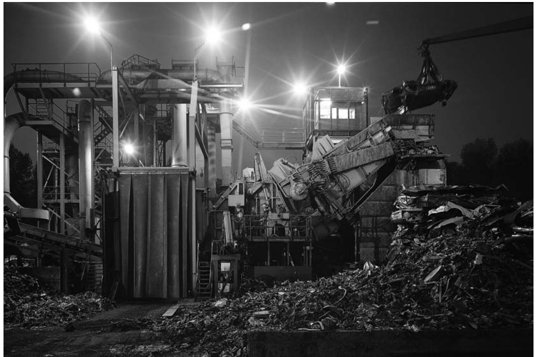
Hergestellt in Düsseldorf: eine Verschrottungsanlage für Autos.
