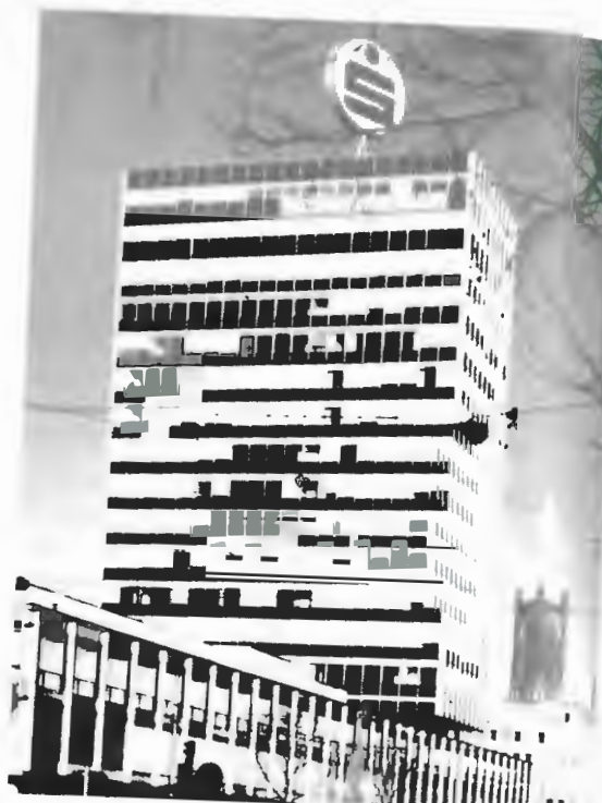
Das Sparkassen-Hochhaus an der Berliner Allee (Foto: Walter Klein)
