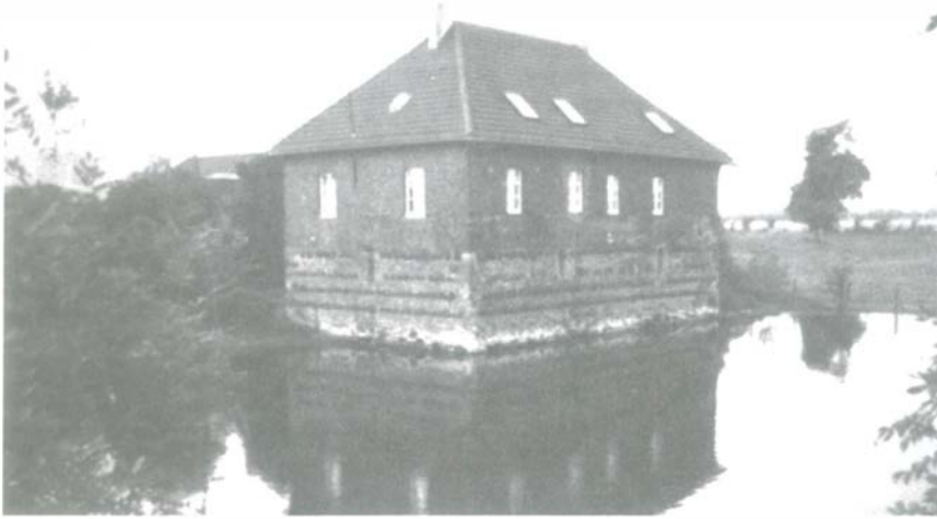
Der heute noch vorhandene Rest der Wasserburganlage Leuchtenberg zeigt im Fundament eine Schichtbauweise, wie sie im 12. Jahrhundert üblich war und auch am Mauerwerk der Burg Friedestrom in Zons ersichtlich ist. (Aus dem Guntram-Fischer-Buch „Lohausen und Stockum“.)
