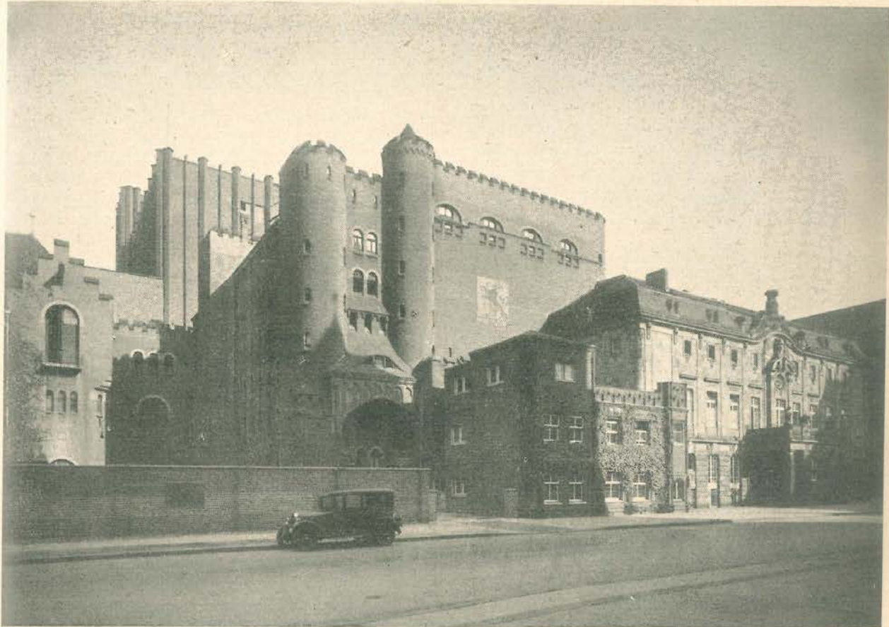
Das Düsseldorfer Schauspielhaus. Blick von der Kasernenstraße auf das Bühnenhaus (Es wurde in einer Bombennacht 1943 zerstört)
