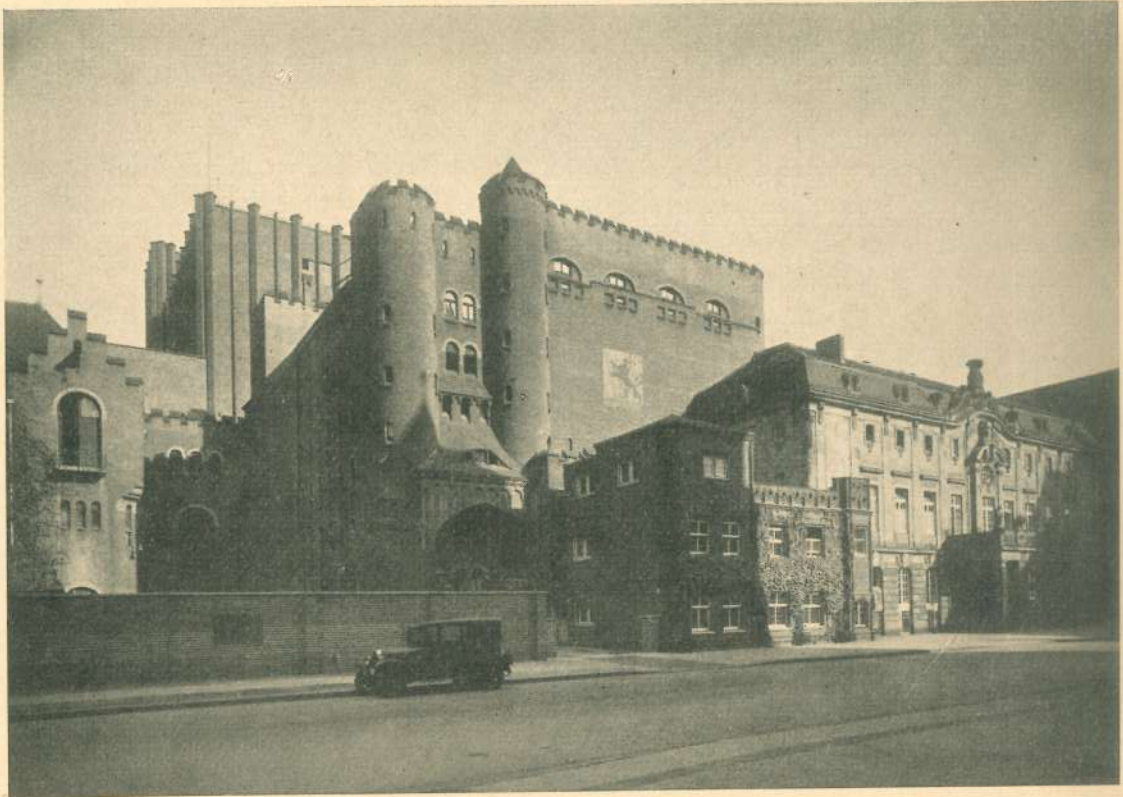
Das Düsseldorfer Schauspielhaus in der Carl-Theodor-Straße (zerstört 1943, endgültig niedergelegt 1954)
