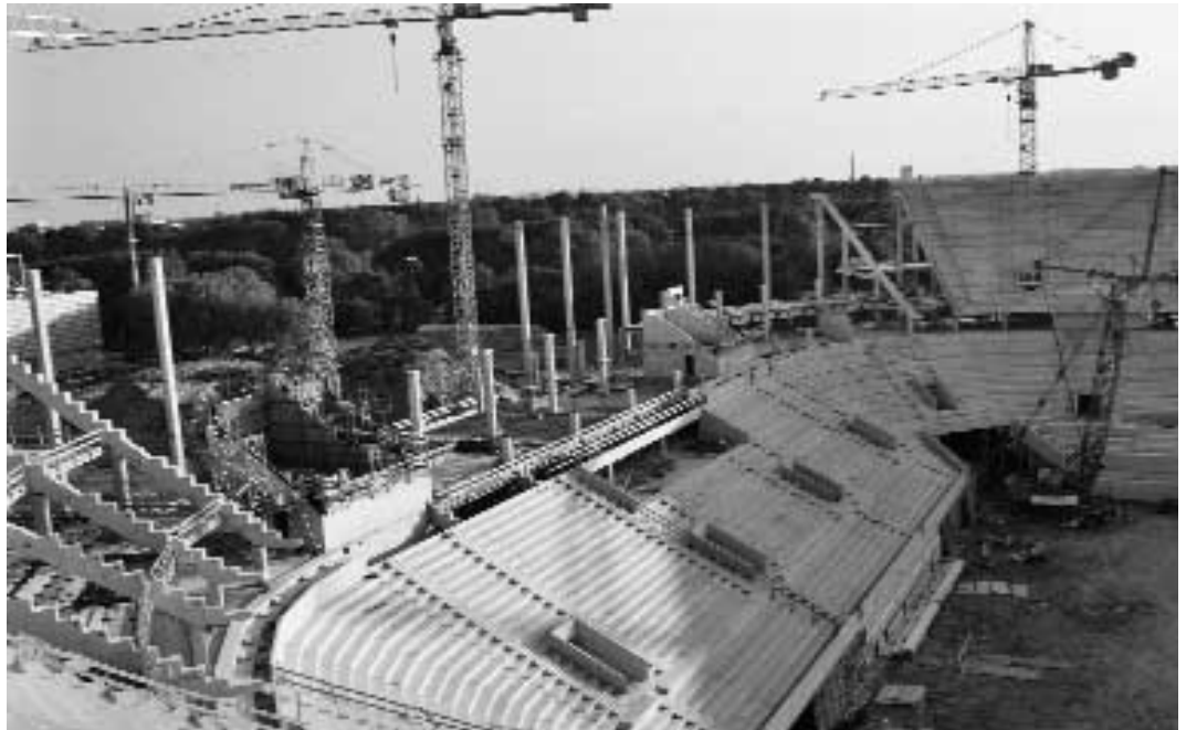
Blick auf die Baustelle der neuen Arena.
