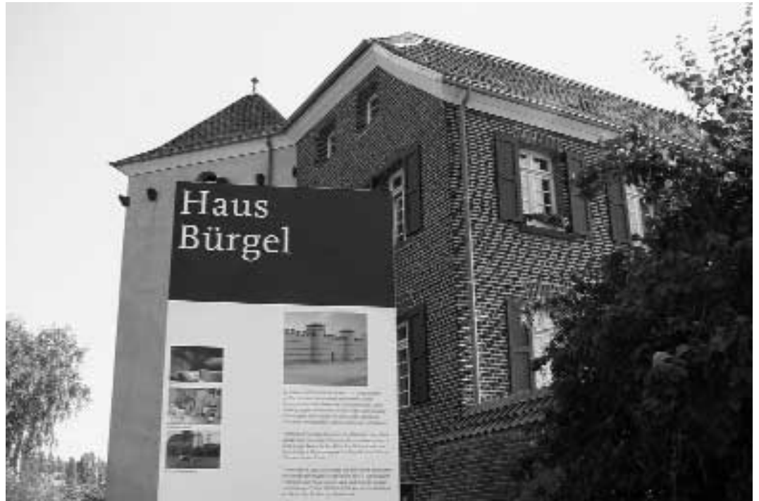
Links im Hintergrund der Turm auf römischem Fundament.
