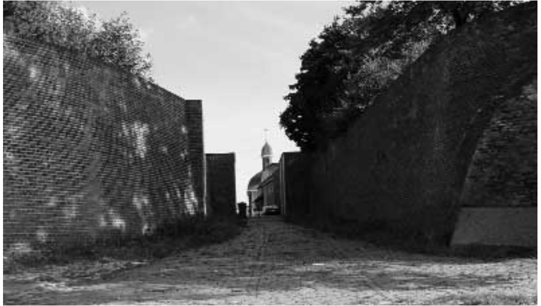
Auch Schutz vor der Flut: das Deichtor von Düsseldorf-Hamm.
