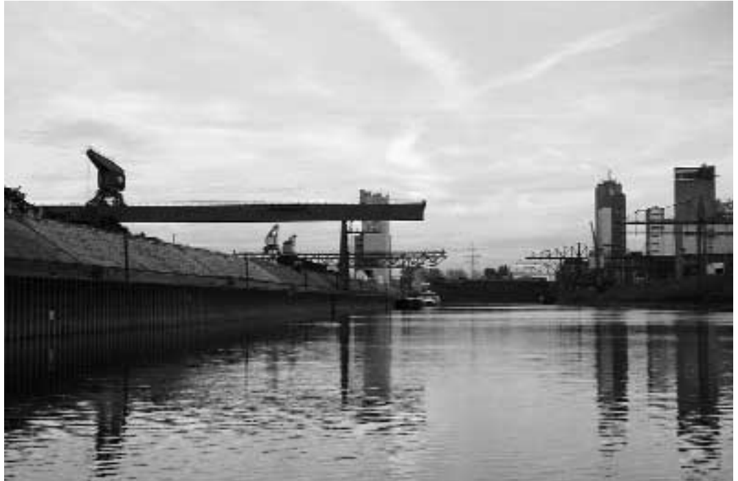
Blick in den Neusser Hafen.
