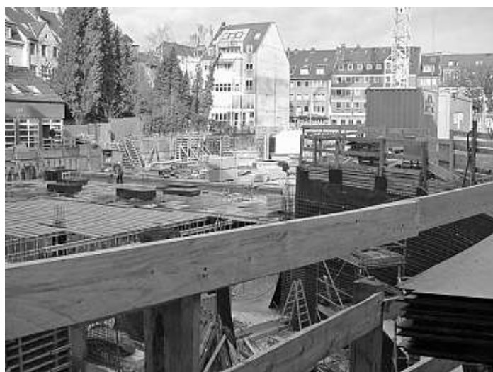
Die Baustelle am Tag der Grundsteinlegung.
