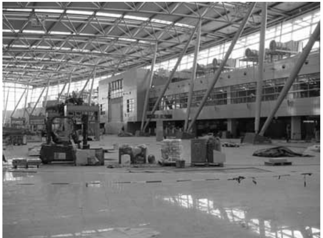
Noch Baustelle, aber bald Festhalle zur Eröffnung: der Flughafenhallenausbau.
