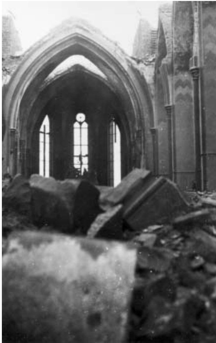
Das Klösterchen in Trümmern.
