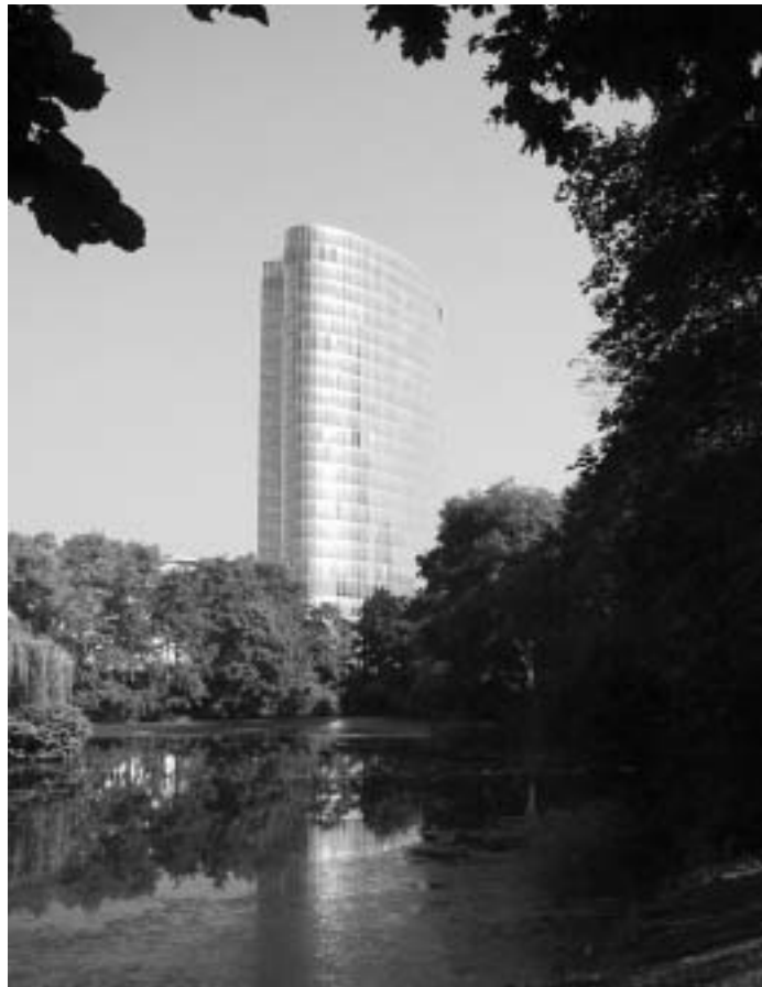
Das neue Hochhaus GAP 15, vom Schwanenspiegel aus gesehen. Dazu auch untenstehender Kasten.
